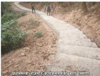
प्रधानमन्त्री रोजगार कार्यक्रमको बाटो निर्माण
