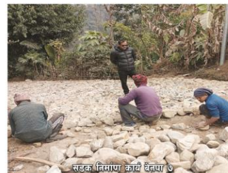
सडक निर्माण कार्य बेतपा ७
