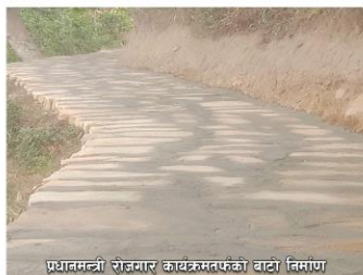
प्रधानमन्त्री रोजगार कार्यक्रमको बाटो निर्माण
