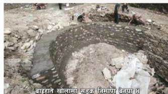
बाह्रहाते खोलामा सडक निर्माण बेतपा ४
